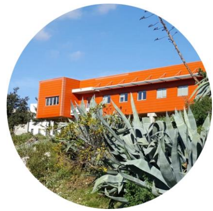
Troisième bâtiment du CINaM Aussi appelé PLANETE (figure 3)
