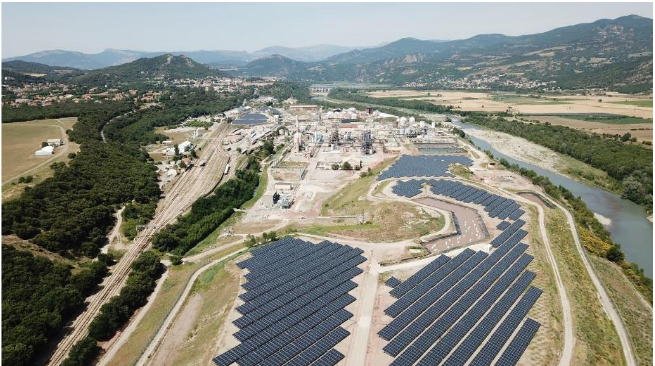
Figure 1 : Site Arkema Saint-Auban
