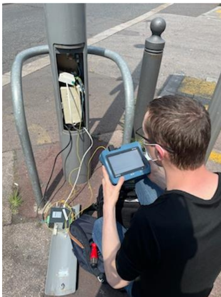
Figure 8 : Intervention sur une caméra de vidéo-surveillance
