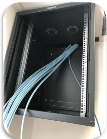
Figure 9: passer les câbles dans la baie de brassage
