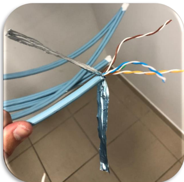
Figure 11: ouvrir les deux derniers Shield et les raccourcir.
