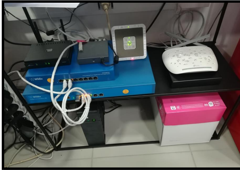
Figure 62 : baie « fait maison »
