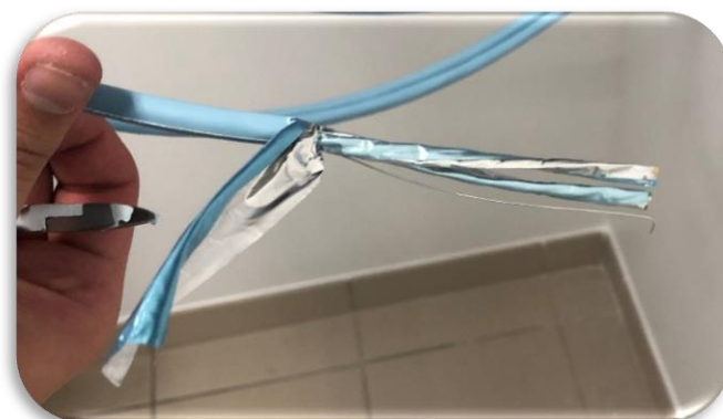
Figure 10: dénuder les câbles et retirer le premier Shield*
