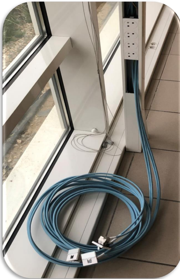
Figure 24 : prise réseaux femelle terminée
