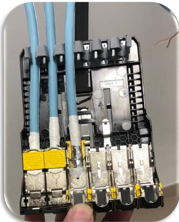
Figure 18: on insère le câble dans le panneau
