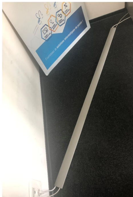
Figure 19 : Cache-câble pvc
