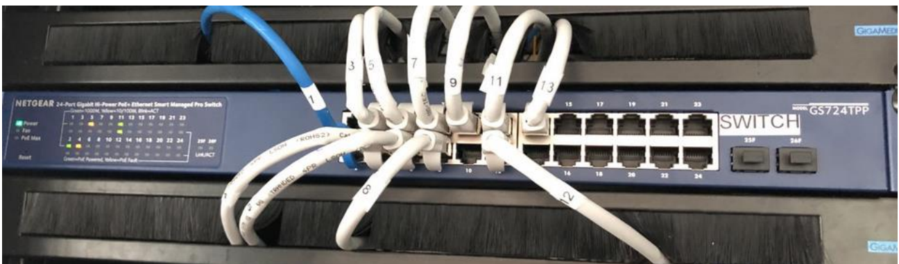
Figure 8 : Switch une fois étiqueter
