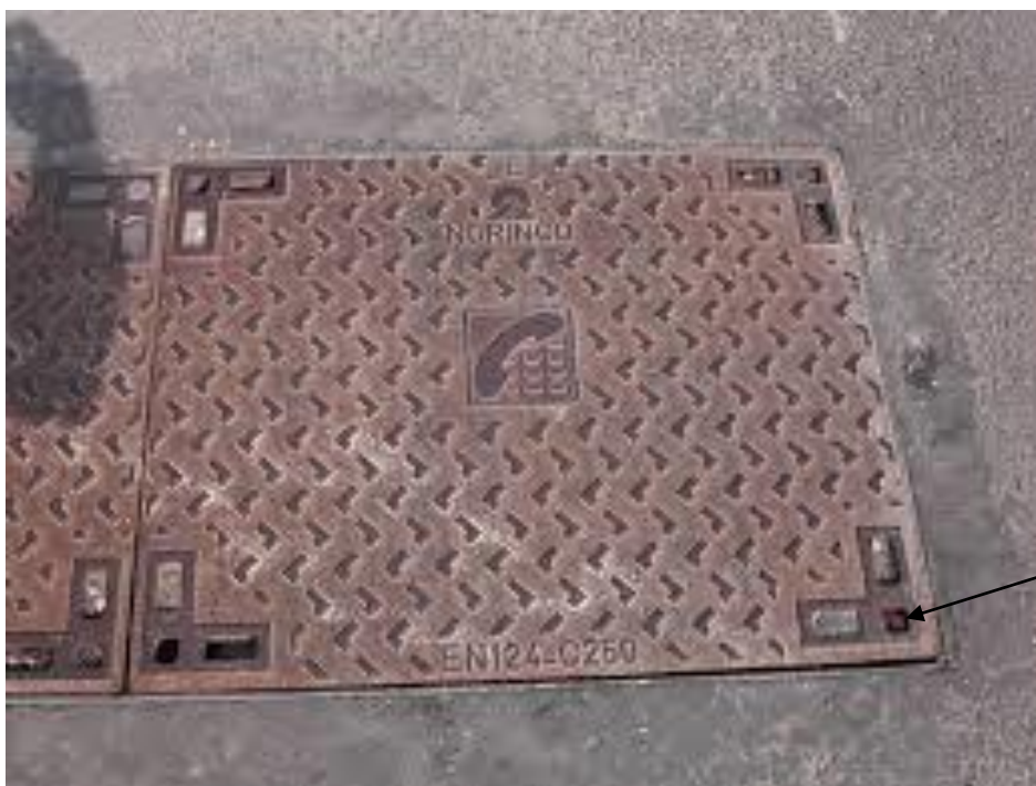
Figure 19 : plaque de la chambre à soulever avec le marteau
