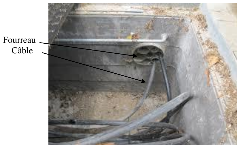
Figure 12 : intérieur d'une chambre
