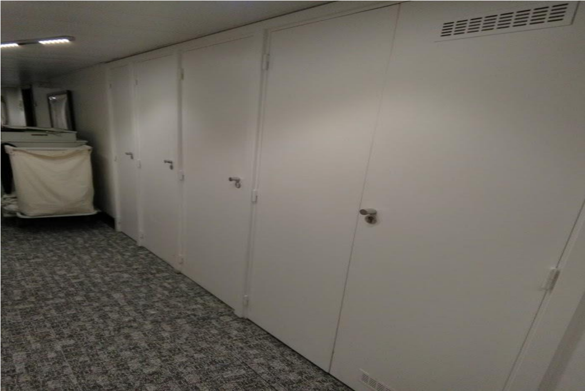
Visite technique Avant installations dans un hôtel
