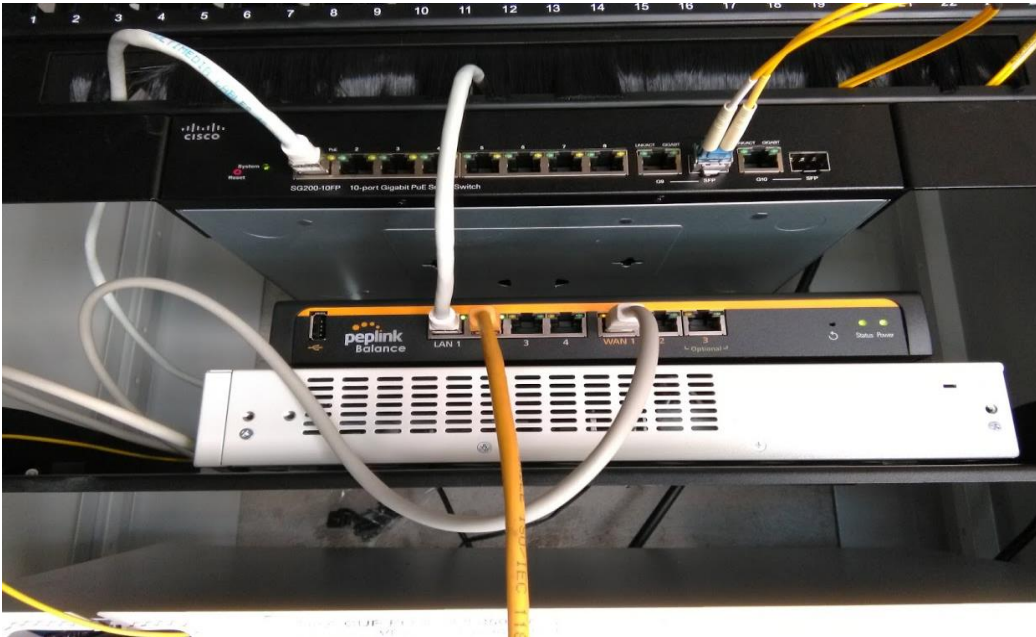
Installation fibre optique chez un client
