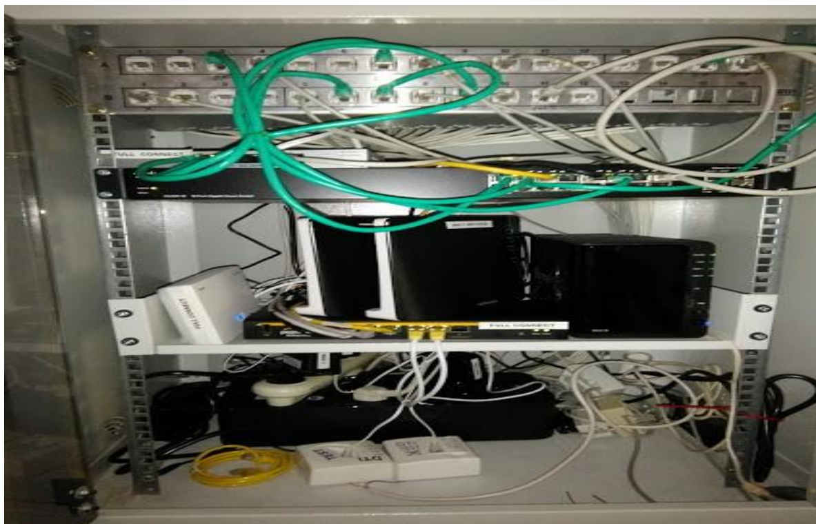
Installation VDSL avec deux WAN chez un client
